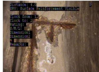
Davy St., Storm - Rebar Visible
