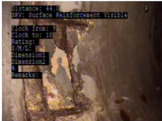
Davy St., Storm - Rebar Visible
